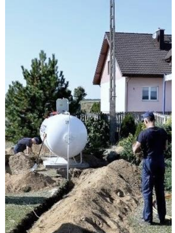
Wykopy liniowe pod instalację
