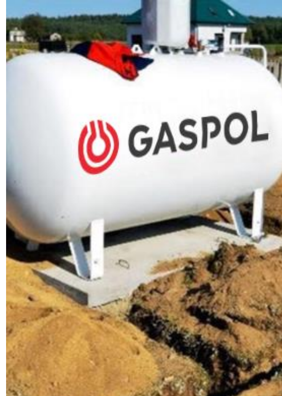
Wykopy pod uziom zbiornika
