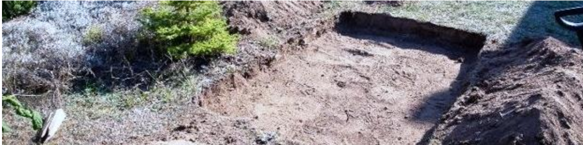
Przygotowanie terenu pod płytę
